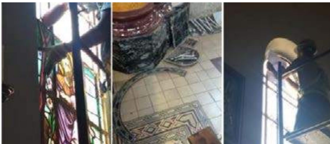
Figura 7: Processo de retirada do vitral São José para restauração
